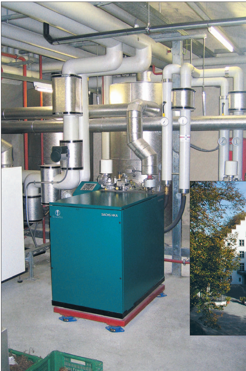
Angewandte Wärme­kraft­kopplung: Hotel Schloss Wartegg mit eigenem Block­heiz­kraft­werk.
